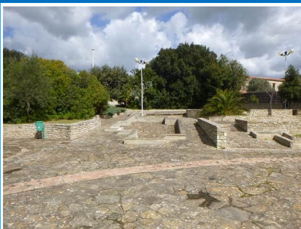
zona in cui andrà realizzata la gradonata: tutte le vasche andranno demolite in quanto, ormai inutilizzate, costituiscono ostacolo per la manifestazioni
