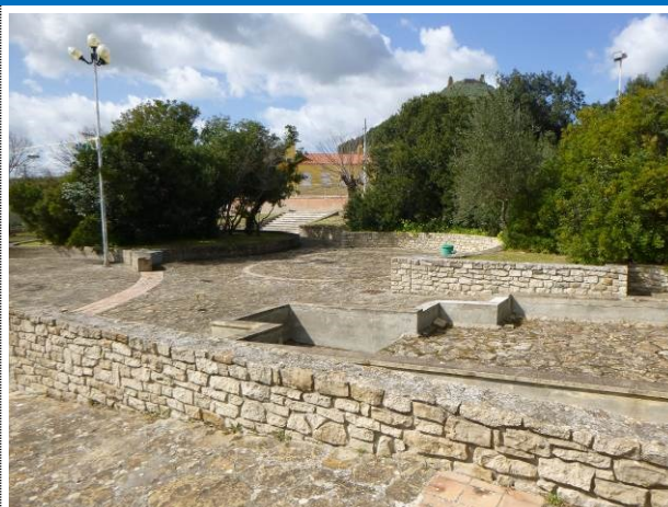
vista dal punto in cui si deve realizzare la gradonata del punto in cui sarà il palco
