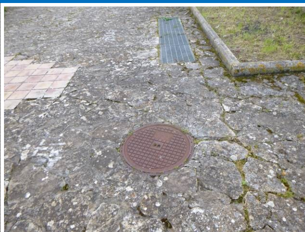
il sistema di raccolta delle acque bianche, costituito da numerose griglie e pozzetti, risulta perfettamente funzionante
